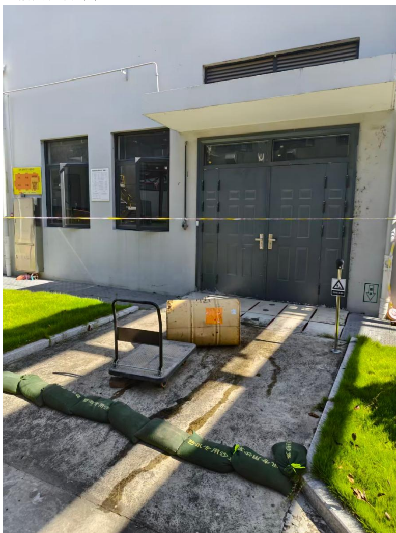
雨水沟沙袋封堵
